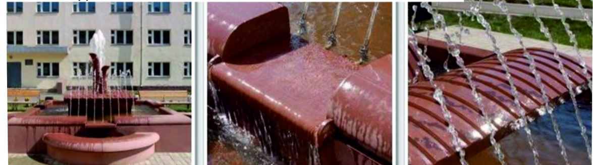
ПРИМЕР ОТДЕЛКИ ЧАШИ ФОНТАНА ПО ТЕХНОЛОГИИ «ПРОКАТ БЕТОНА»
